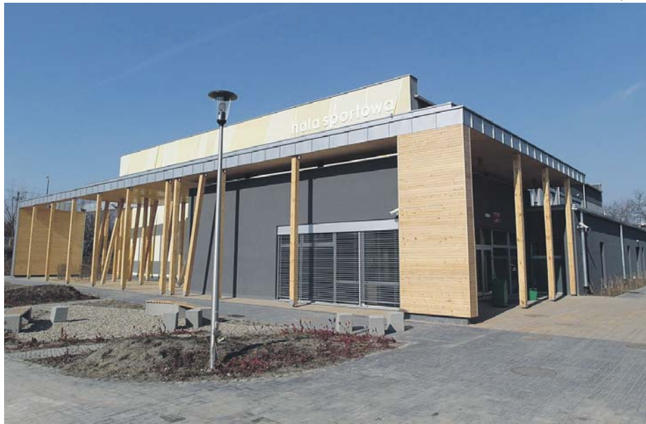
Първата зелена спортна зала в Краков, Полша, на Университета по земеделие. 30% от покрива на сградата е покрит с трева, има и отлична вентилационна система. Проектирана е по стандартите на пасивна къща с разход на енергия от 15 kWh/m 2 годишно. Тя е една от най-икономичните спортни зали в Европа
